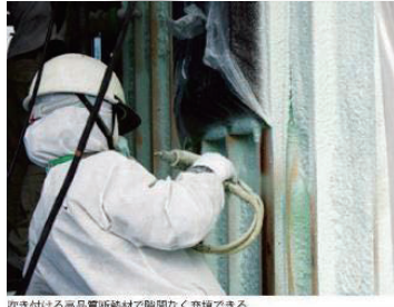
吹き付ける高品質断熱材で隙間なく充填できる
